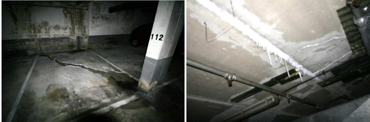
Fotografías de goteras y humedades actuales.
